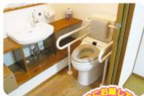
トイレ/手すり・扉もたれ取付、開口部拡張
