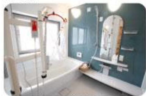
浴室/システムバス設置、介護用リフト取付
